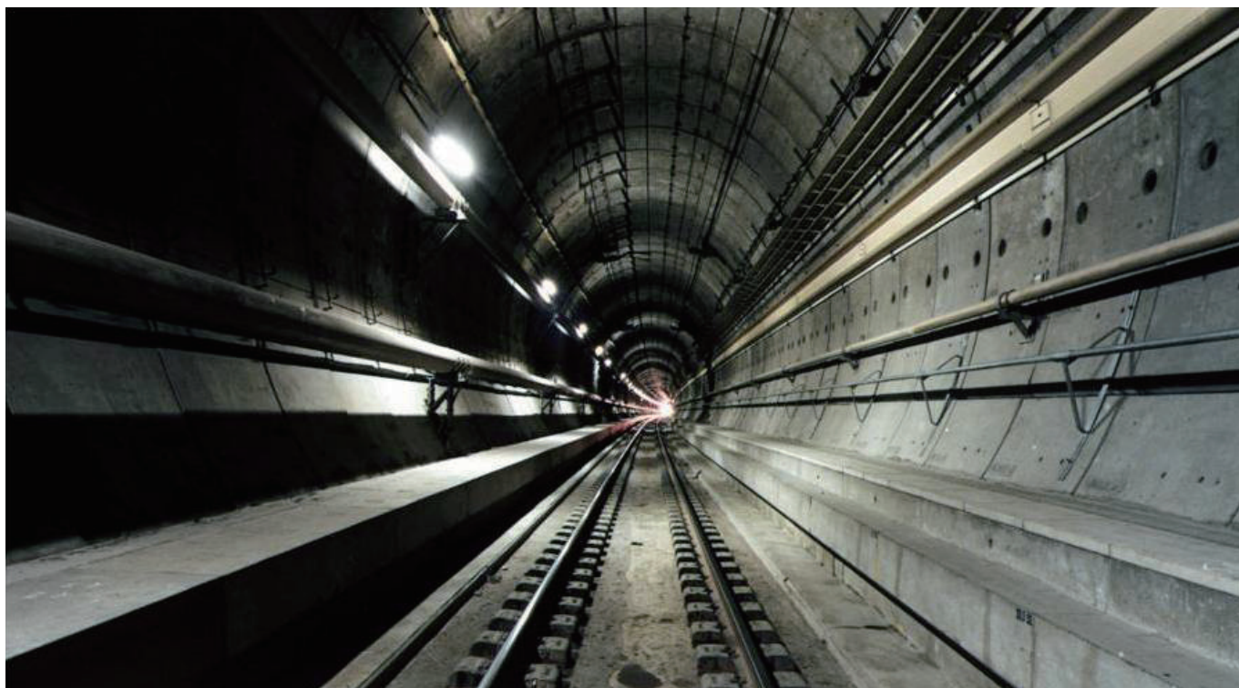
走行トンネルの内部
