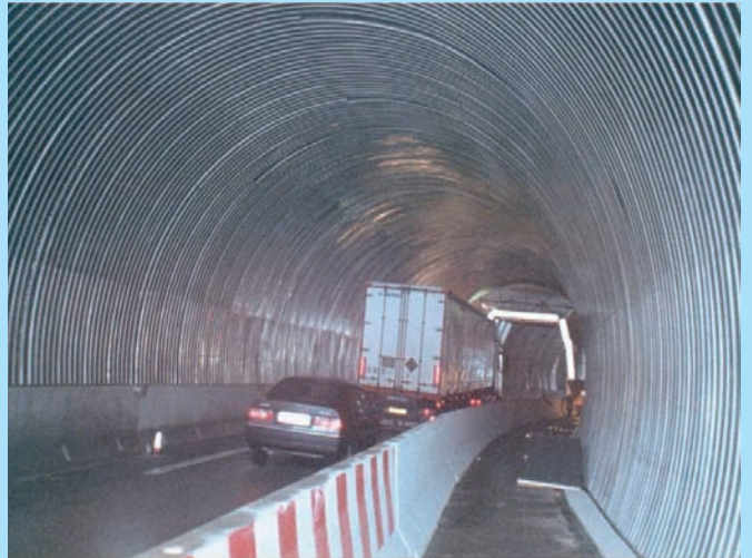
12,000m 2 を超えるステンレス・メッシュが通行車両をコン クリートの碎片から保護している。
