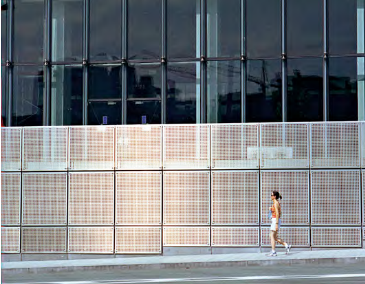
An der Fassade des Charlemagne-Bürokomplexes in Brüssel (B) hat sich gebürstetes und geschliffenes Lochblech bewährt.
