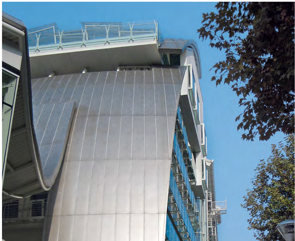
Teile der Gebäudehülle, die der Witterung ausgesetzt sind, werden durch Regenwasser wirksam gereinigt. Foto: Centro Inox, Mailand (1)
