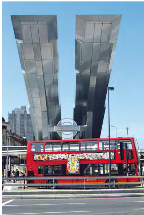
Für den Vauxhall-Cross-Busbahnhof in London wurde einer mustergewalzten Oberfläche der Vorzug gegeben, um den Reinigungsaufwand zu minimieren.
