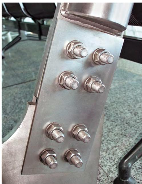
Sui componenti in acciaio inox, usare solo bulloneria dello stesso materiale.
