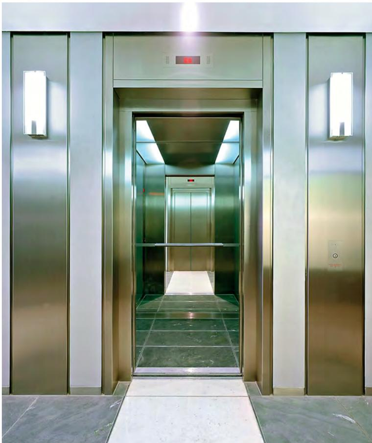
Oggi sono disponibili anche speciali finiture “rolled-on” il cui aspetto è simile a quello della lucidatura o pallinatura. Realizzate sul treno finitore, esse presentano una trama molto coerente che conserva la stessa micro-ruvidità delle finiture lisce. Nelle applicazioni interne, la pulibilità di questi laminati è buona, mentre nelle applicazioni esterne come elementi di copertura, basta la pioggia a lavare via lo sporco.
