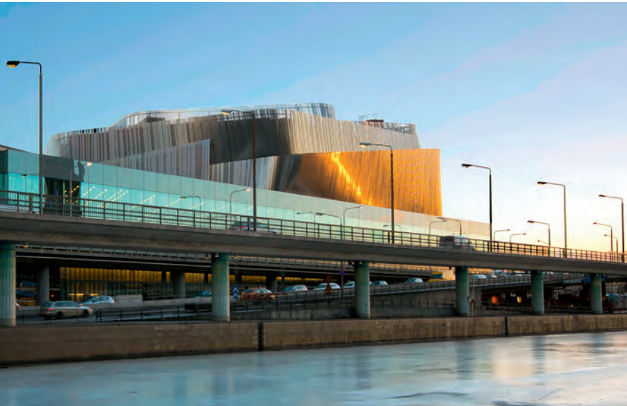
Kongresová hala s fasádou tvořenou lamelami z korozi-vzdorné oceli se majestátně zdvihá nad silnicí, železniční tratí a vodami jezera.
