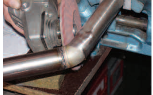
Kulma, joka on valmistettu käyttämällä putkikäyrää
