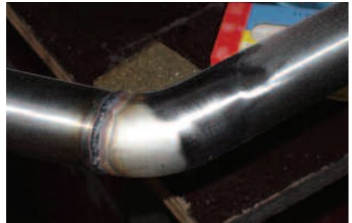
Terävä sisäkulma puuttuu
