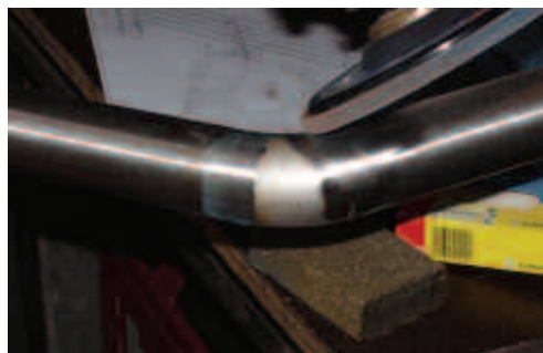
L'intero perimetro del giunto può essere sottoposto a trattamento preliminare eseguito semplicemente con dischi abrasivi a lamelle
