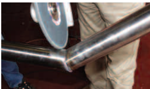
Trattamento dell'angolo interno con utensile di finitura per angoli interni
