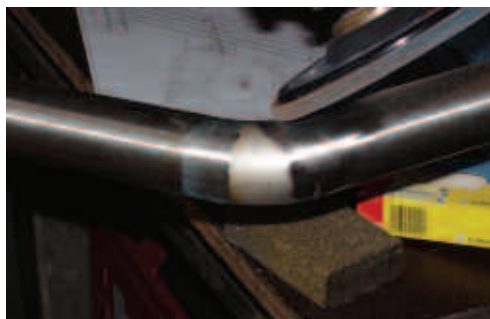
Runt röret samt hela fogen kommer man åt att slipa med en lamellrondell
