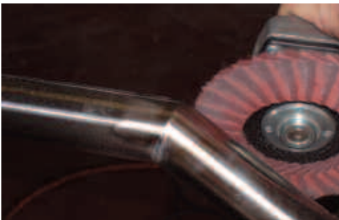
Behandling utav utsidan med en polerande lamell-rondell
