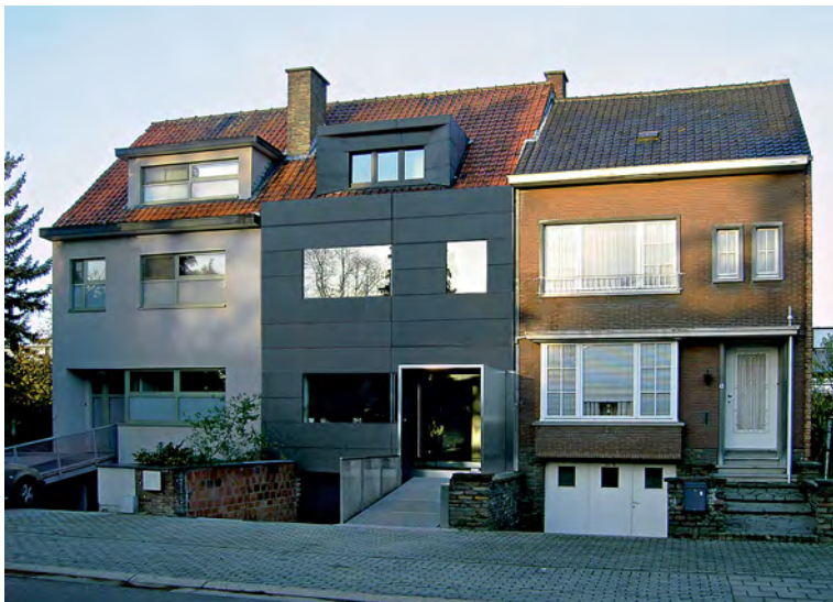
Een deel van de inkomluifel springt naar voren ten opzichte van de gevel van vezelcementplaten.
