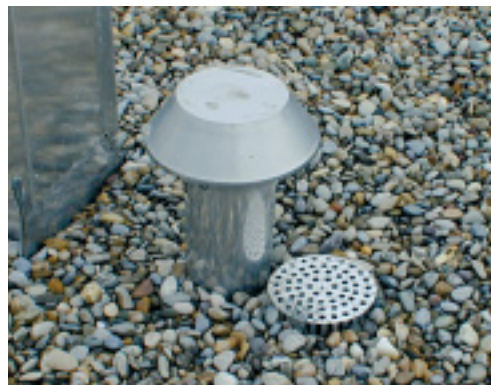
Ruostumattomasta teräksestä valmistettu alipaineaivo.
