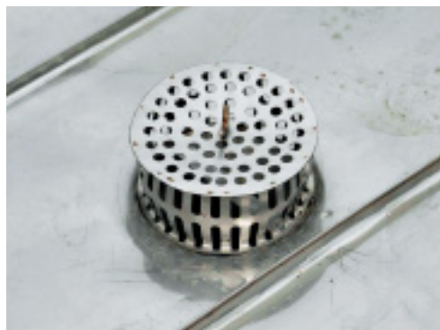
Ruostumattomasta teräksestä valmistettu alipaineaivo.
