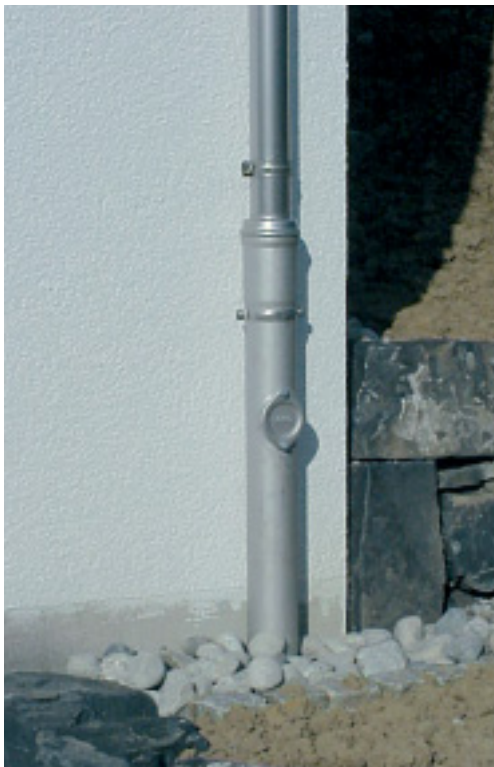
Syöksytorvi, jossa on puhdistusaukko.
