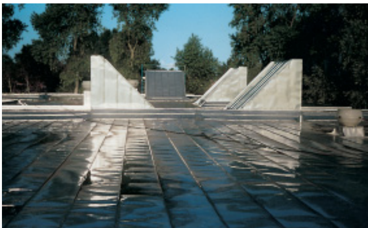
2B tehdasvalmis pinta on kustannustehokas ratkaisu tasakattoja varten.
