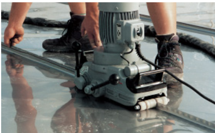
Vaikka saumataitosta ei tarvita vesitiiviyyden parantamiseksi, se vahvistaa liitosta ja poistaa terävät reunat.
