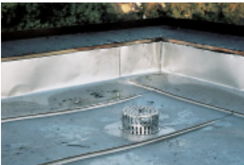
Sumidero hecho a medida (arriba), sumidero instalado incluyendo filtro de desagüe (abajo).
