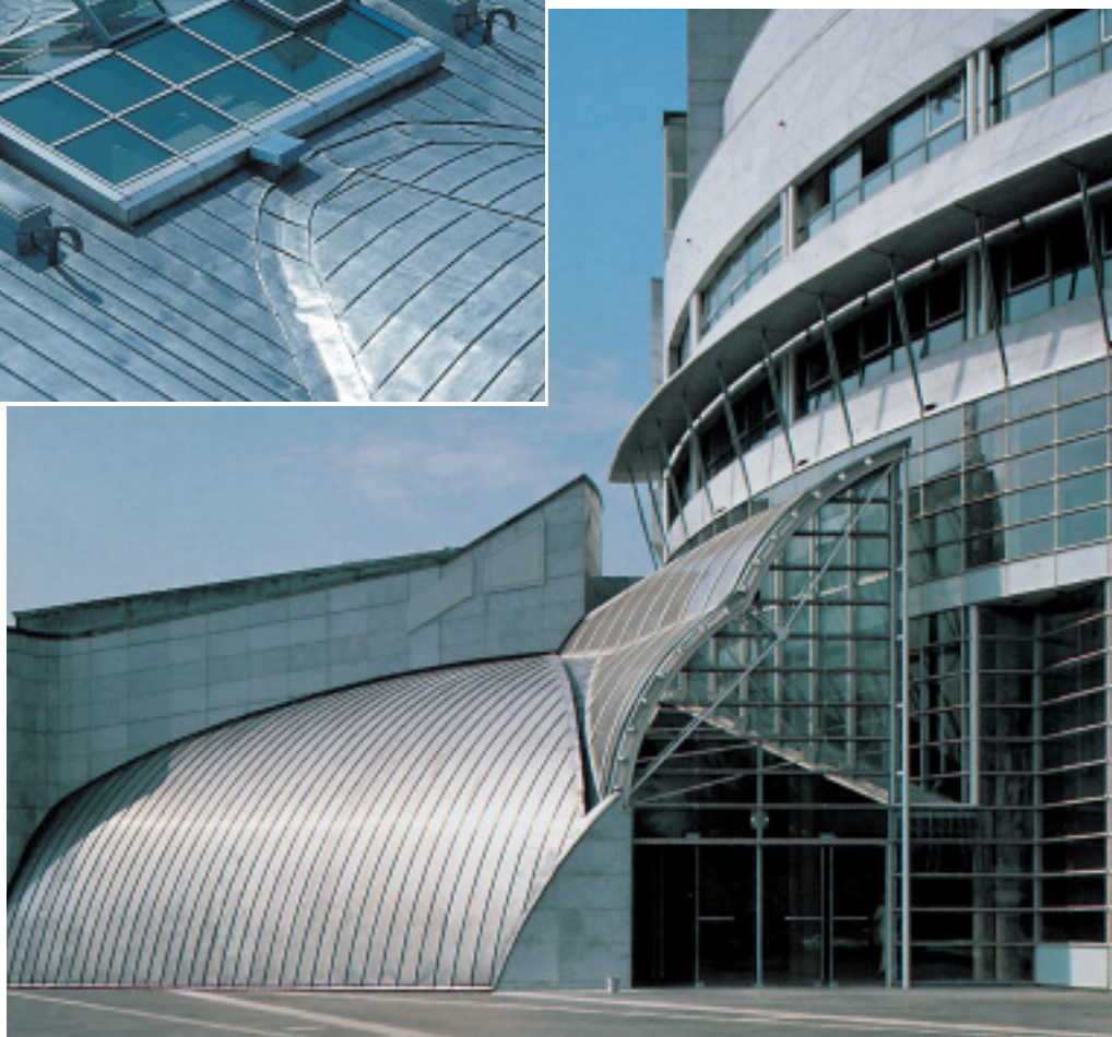
El método de costuras fijas es apropiado para techos inclinados y curvos.
