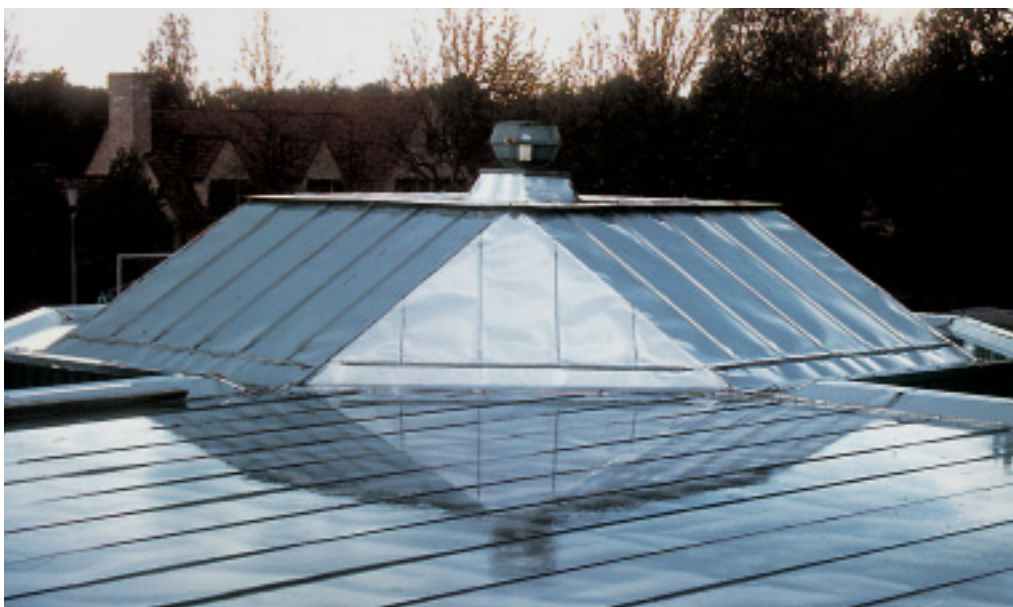
La técnica de soldadura para la construcción de tejados es similar a la empleada para revestimientos interiores de tanques de agua.
