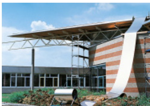
Les bobines d'inox ont été mise à longueur sur le site.
