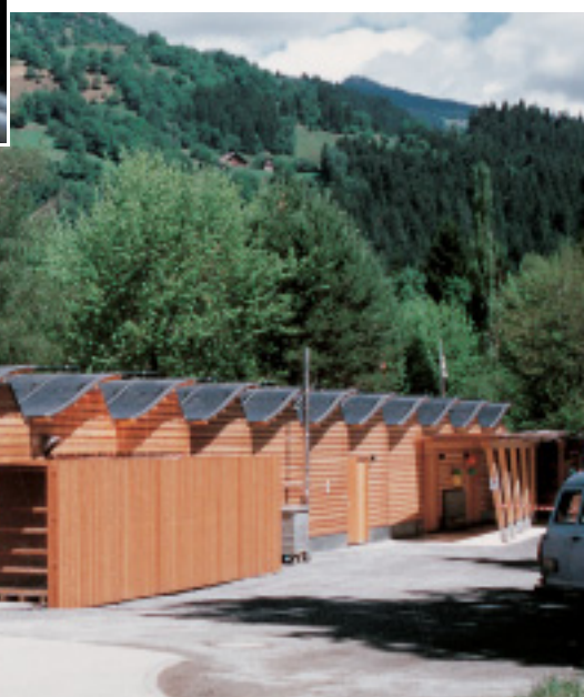
La toiture en forme de vague met en relief sa double fonction.
