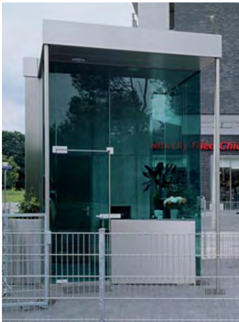
Die großen, wartungs-freundlichen Flächen aus grünem Glas und nicht-rostendem Stahl betonen die spannende Form des Häuschens, die durch das einfache Verdrehen zweier Quader entsteht.
