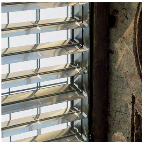
In een meer recente verbouwing werd het daglicht in de ruimte gemaximaliseerd door gebruik te maken van hooggepolijste louvres, ingebouwd tussen de dubbele beglazing in de hoge boogramen.
