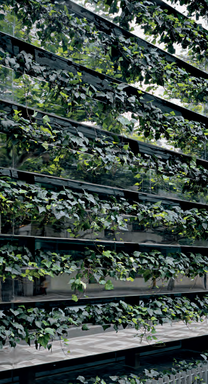
Växter i spegelblanka lådor förvandlar fasaden av stål och glas till en grönskande vägg.
