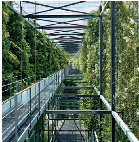
Utrymmet mellan de dubbla väggarna är fyllt med trappor, övertäckta gångbroar och utbyggda balkonger.
