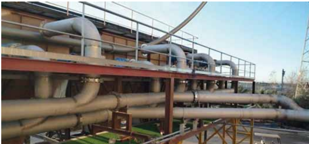
Widok oczyszczalni ścieków z instalacją, gdzie rury i barierki wykonano ze stali nierdzewnej Zdjęcie: Cedinox, Madryt (E)
