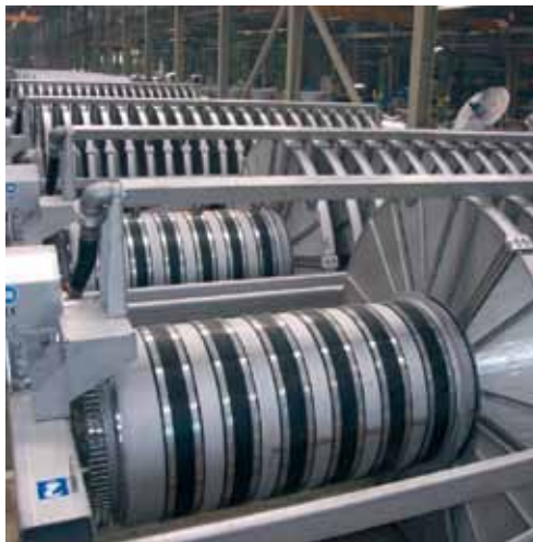
Mikro-filtry do usuwania zawiesiny drobnych zanieczyszczeń stałych z odpływu wtórnego osadnika ścieków Zdjęcie: Hans Huber, Berching (D)
