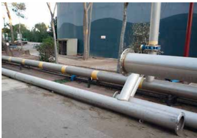
Systemy rurowe przed montażem w oczyszczalni ścieków
