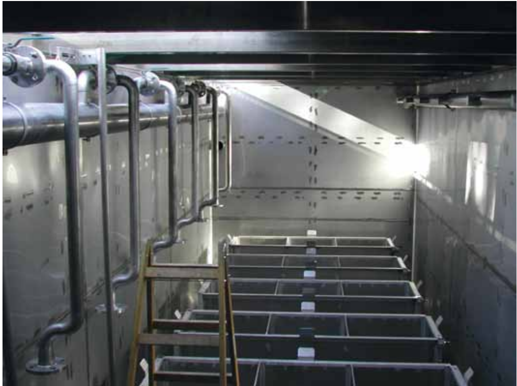
Wnętrze zbiornika z obudową membrany ze stali nierdzewnej Zdjęcie: Centro Inox, Mediolan (1)
