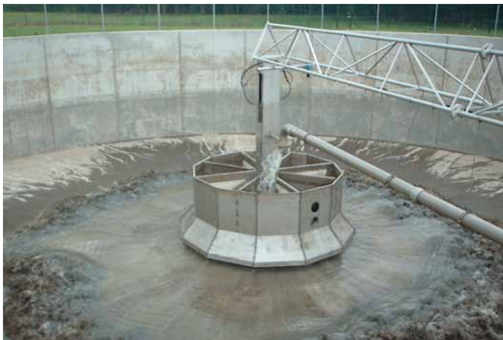
System splotkiwania w okrągłym zbiorniku – falowe splotkiwanie dla zbiorników okrągłych i małych prostokątnych Zdjęcie: Steinhardt Wassertechnik, Taunusstein (D)
