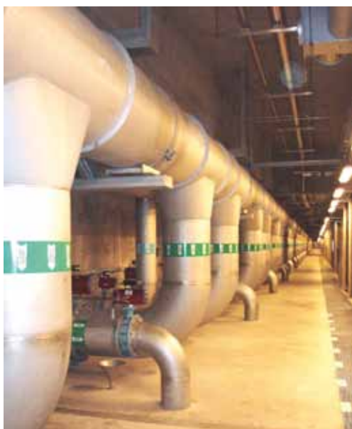
Instalacja rurociągów pod piaskownikami w oczyszczalni ścieków w Sztokholmie (S) Zdjęcie: Outokumpu, Avesta (S)
