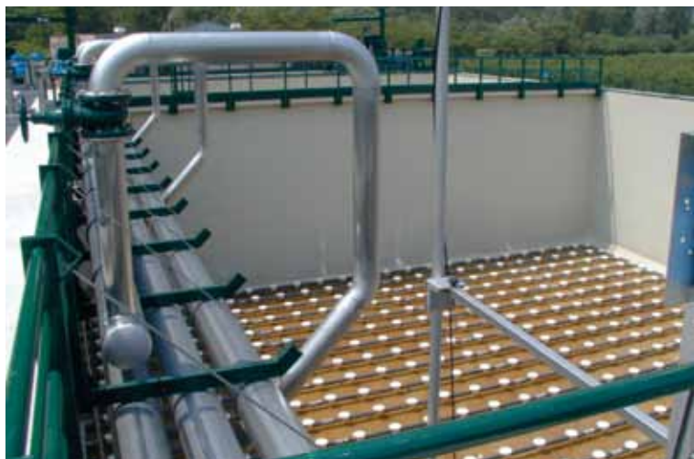
Nieizolowane i malowane powierzchnie ze stali nierdzewnej stosowane w Lavis (I)
