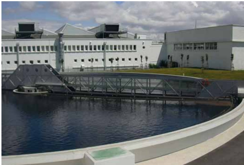
Widok na komorę napowietrzania w oczyszczalni ścieków Zdjęcie: CDA La Rochelle (F)
