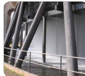
Nuance 1.4003/410, grille-enveloppe en X pour tour de refroidissement, Afrique du Sud
