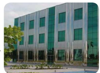
Panneaux de la façade (partiel) en 444, Brésil.
