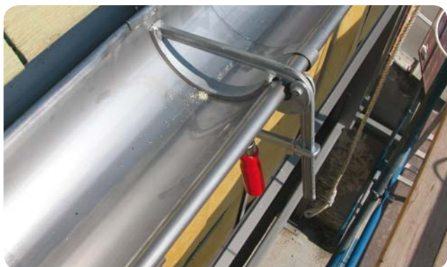
Fixation de gouttière en 430Ti revêtu d'étain.
