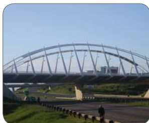
Nuance 1.4003/410 peinte, SASSDA, Afrique du Sud (pont en service depuis plus de huit ans).
