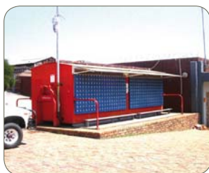
Nuance 1.4003/410 peinte, SASSDA, Afrique du Sud. Les ferritiques à basses teneurs en chrome sont souvent peints lorsque l'esthétique est essentielle.
