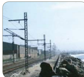
Nuance 1.4003 (première application majeure en 1982 sur la côte à 10 m des vagues : aucune corrosion), Afrique du Sud
