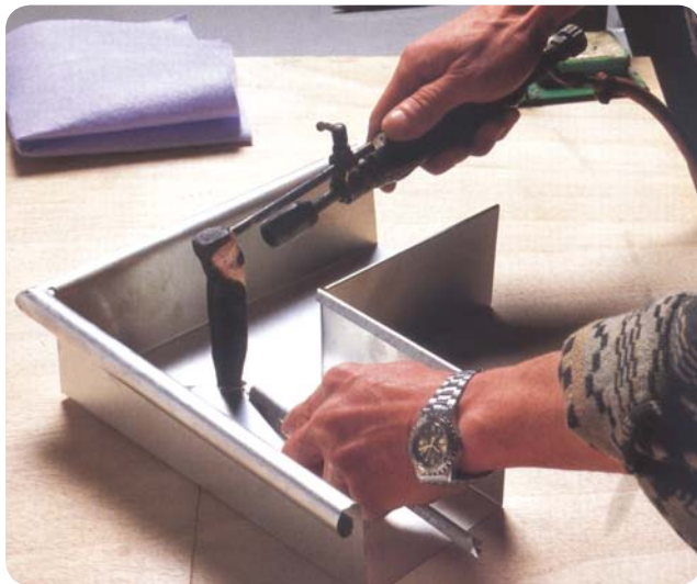
Soudage d'une gouttière en nuance 430Ti revêtue d'étain.
