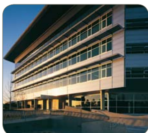
Nuance SUS445M2, finition mate à faible réflectivité, ASSDA, Australie
