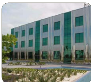
Nuance 1.4521/444 n° 4 brossée (plaques horizontales), Vivo Building, Rio De Janeiro, Nucleo Inox, Brésil (environnement côtier)
