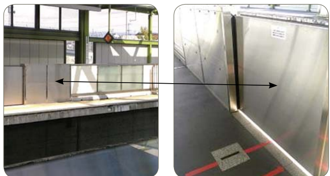
Barrière de sécurité - quai de gare en SUS430 J/L, Japon.
