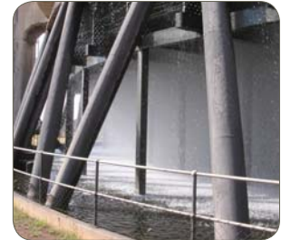
1.4003 (410), Tragkonstruktion (Kühlturm), Südafrika
