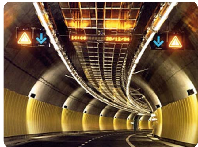
Verkleidungsbleche aus beschichtetem 1.4016 (430), Italien.
