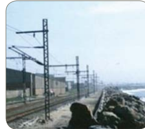
1.4003 (410) (erster größerer Einsatz 1982, entlang der Küste, 10 m entfernt von der Brandung, keine Korrosion), Südafrika
