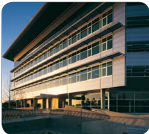
SUS445M2, reflektionsarme, matte Oberfläche, ASSDA, Australien
