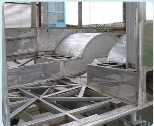
Geschweißter Konstruktionsrahmen aus 1.4003 (410).
