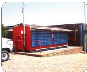
1.4003 (410), lackiert, SASSDA, Südafrika. „Gebrauchs“-Ferrite werden oft lackiert, wenn die Optik im Vordergrund steht.
