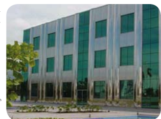
Teilverkleidung eines Gebäudes aus 1.4521 (444), Brasilien.
