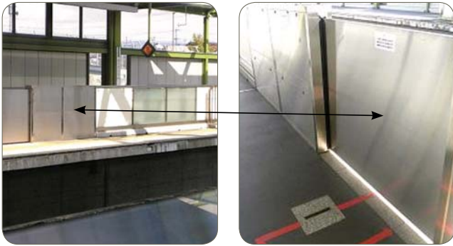
Sicherheitsbarriere (Bahnhof aus SUS430L, Japan)
