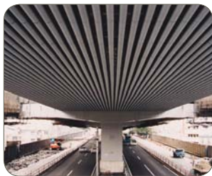
陸橋の防音板
