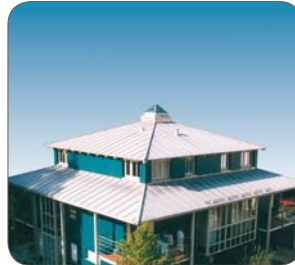
1.4510/430Ti (スタンディング・シーム技法)、 Ugine & Alz, ドイツ
