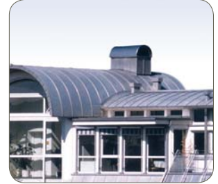
430Ti (スタンディング・シーム技法)、 Ugine & Alz, オーストリア
