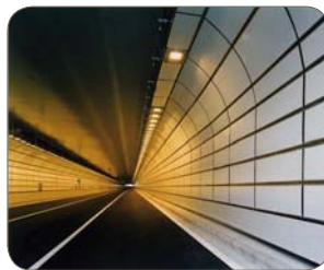
トンネル内壁
