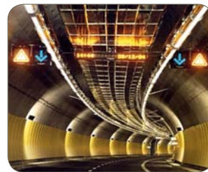
トンネル内壁
