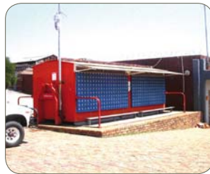
1.4003/410, 塗装加工, SASSDA, 南アフリカ。 「汎用」フェライト系ステンレス 鋼は美的外観が重要な場合 にはしばしば塗装されます。
