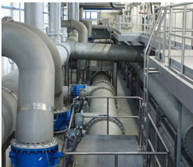
The range of alloys used goes from 304 (EN 1.4301) to 904L (EN 1.4539)
