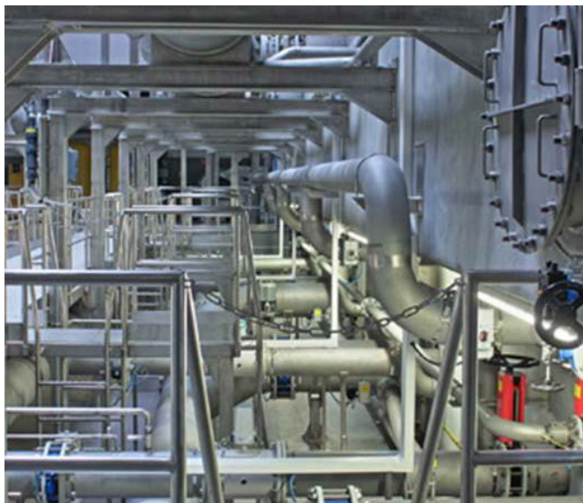
The range of alloys used goes from 304 (EN 1.4301) to 904L (EN 1.4539)
