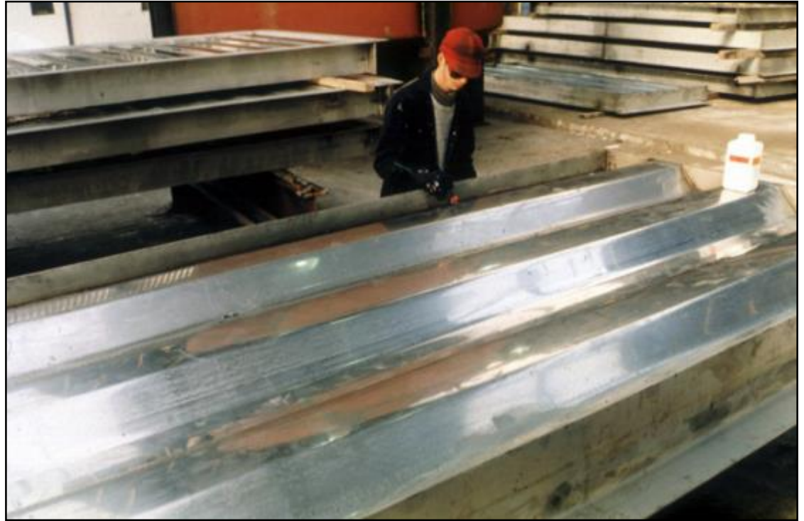
正在生产海洋平台上端的梯形抗暴墙。
