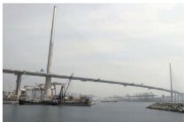
图片 1: 昂船洲大桥全景
