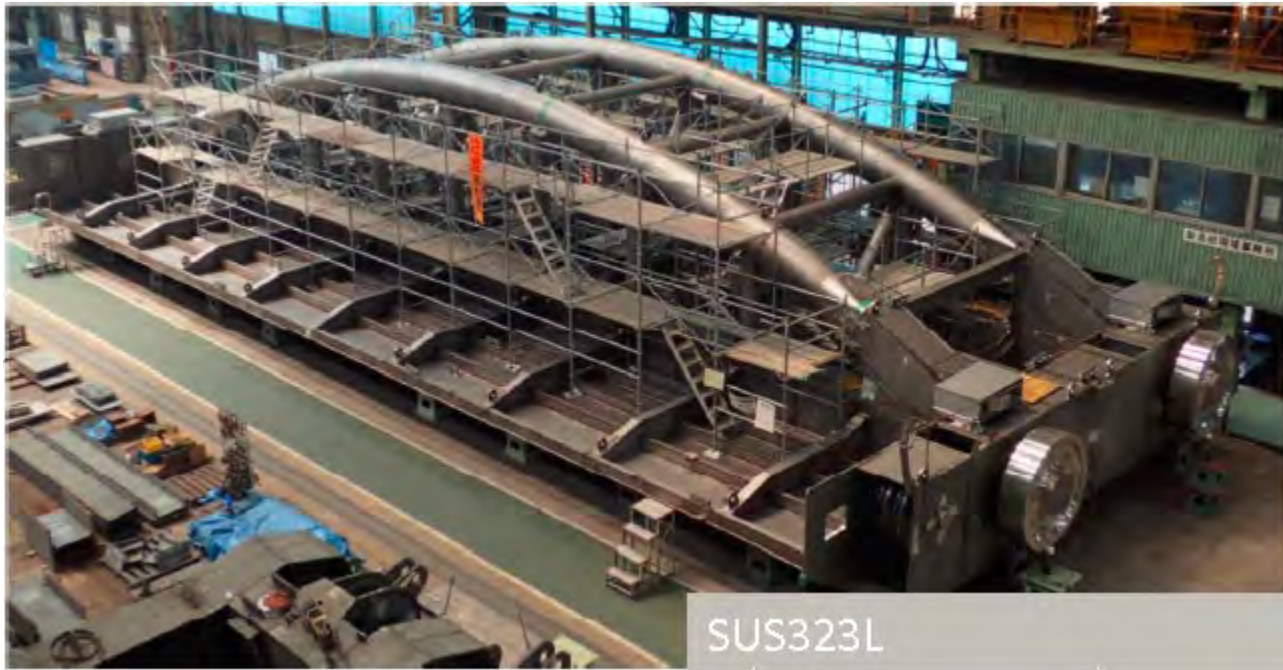
Vista della paratia durante la sua realizzazione
