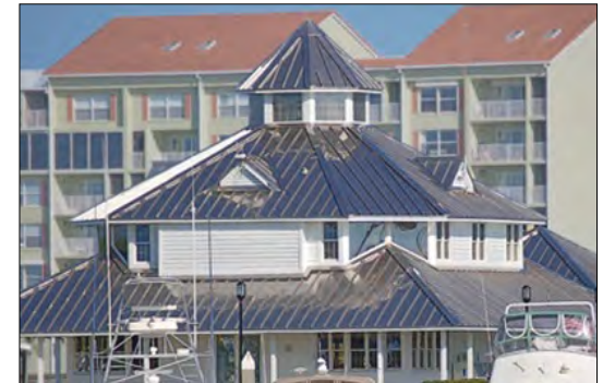
Sistema in acciaio inossidabile per la copertura di tetti, più di 50 anni
