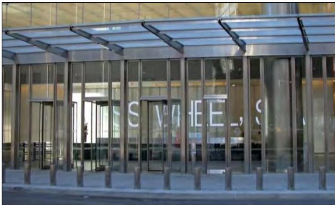
Colonne resistenti allo scoppio nella tettoia d'ingresso, Seven World Trade Centre, New York
