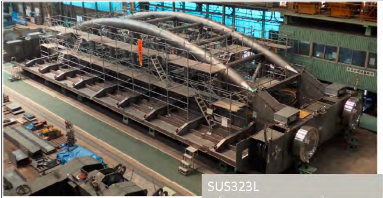
建造中の水門
