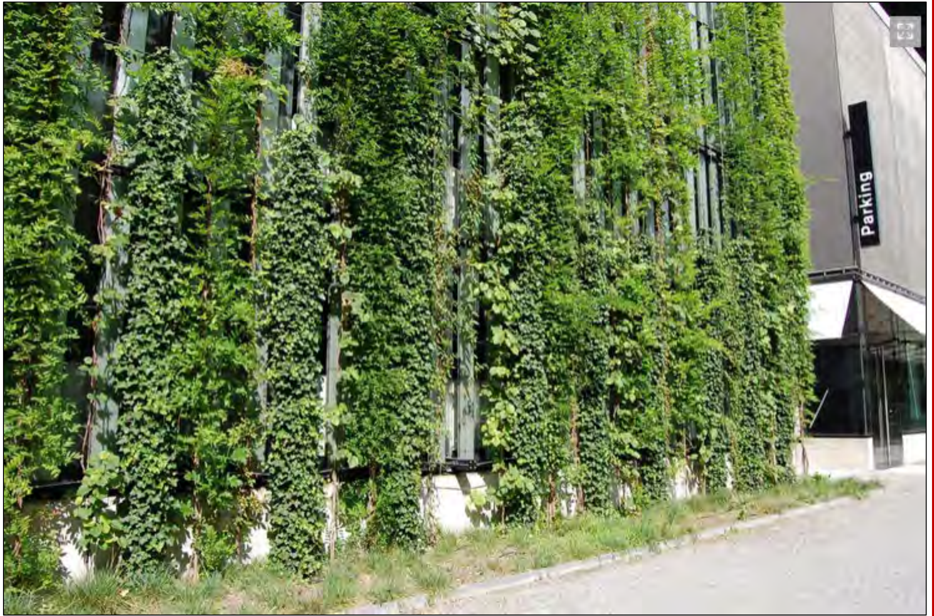
壁面緑化工法 施工例 3
