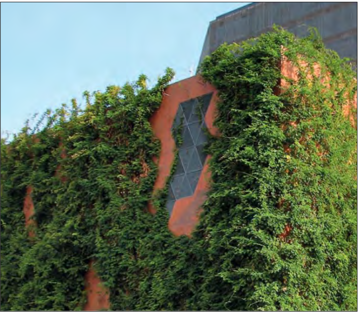
壁面緑化工法 施工例 1
