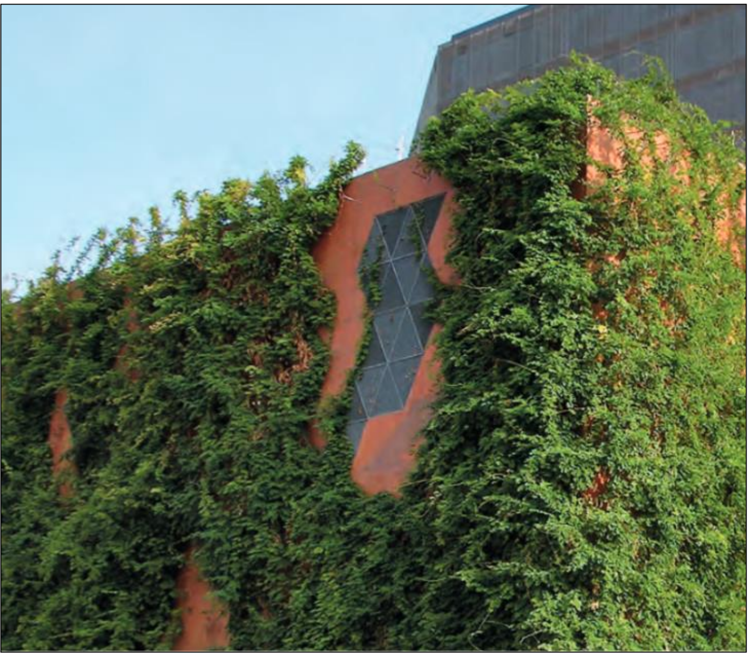
壁面緑化工法 施工例 1
