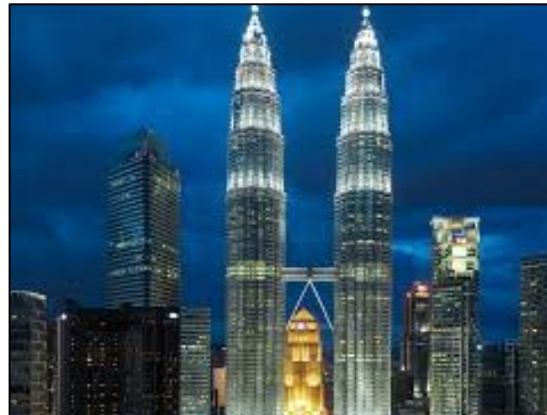
ペトロナスツインタワー クアラルンプール(マレーシア)
