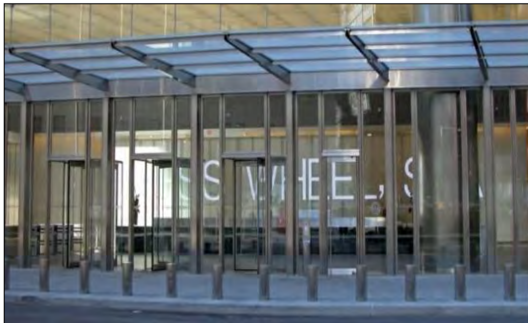
Słupy odporne na wybuch w zadaszeniu przed wejściem, Seven World Trade Centre, Nowy Jork
