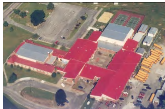
Metalowe pokrycie dachowe, 40-50 lat
