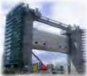
Kotonoura Gate (SUS316LN) Hikata Gate (SUS323L)
