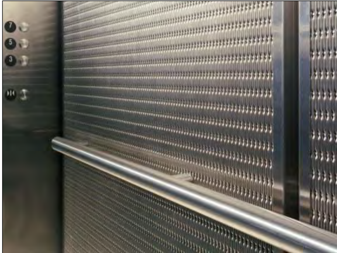
Forro con malla de inoxidable en ascensor 3
