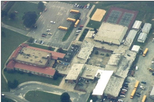
Sistema de cubierta convencional, ~30 años
