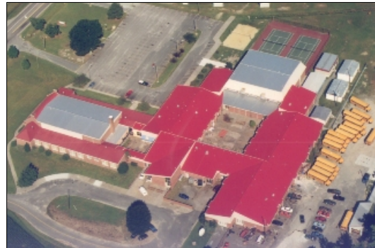
Sistema de cubierta metálica, 40-50 años
