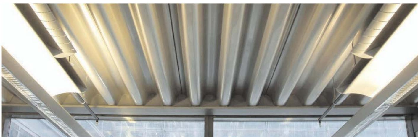
图片 1: 压型不锈钢顶板
