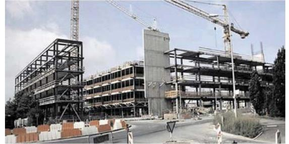
图片 9: 建设钢铁结构框架
