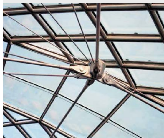
图 2: 铸造不锈钢接头以及反射玻璃构造照片
