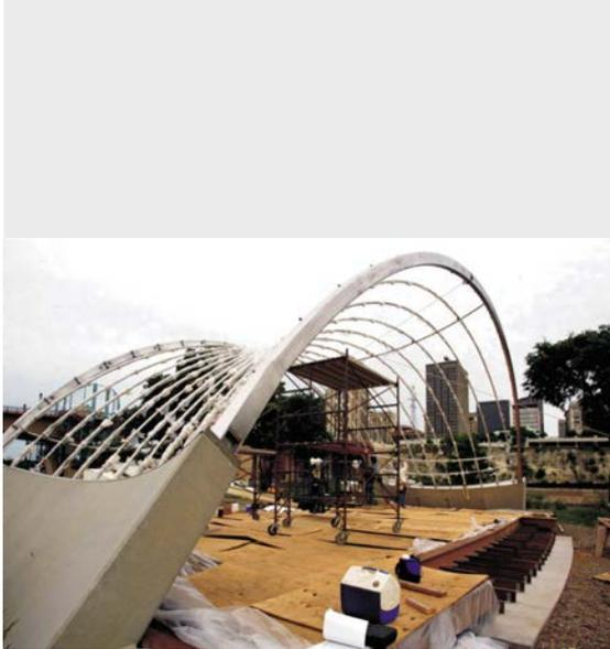
图 6: 弯曲边梁和网架构件的安装
