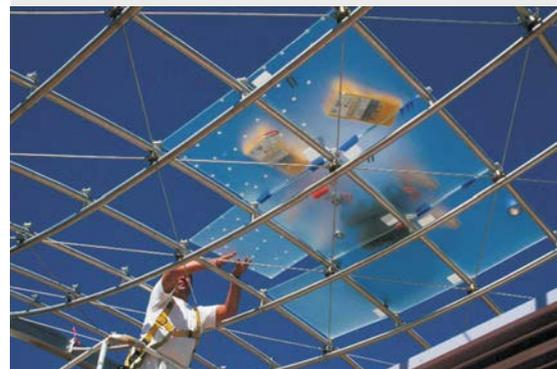
图 8: 玻璃顶板的安放
