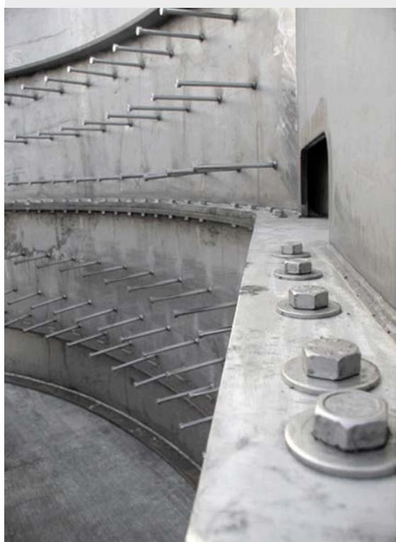
图片 6: 边线法兰的连接
