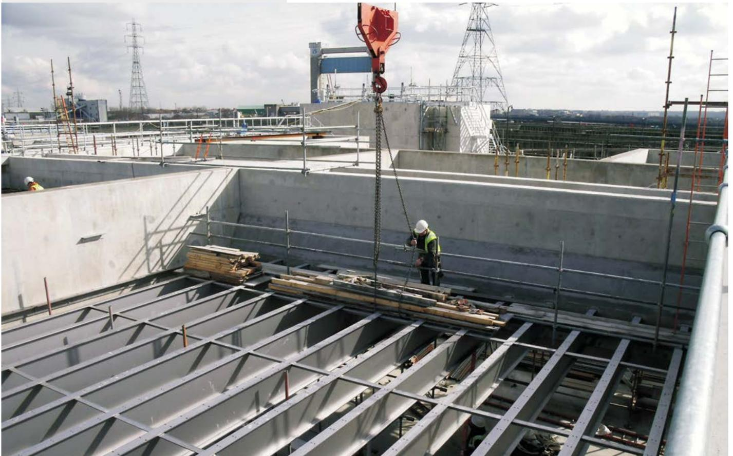
图 7: 完工后的同向流斜板钢结构
