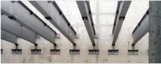
图 5: 工字梁与混凝土壁的连接方式
