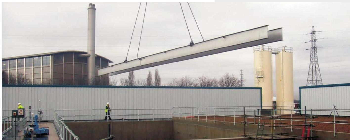
图 8: 一对主工字梁的安装
